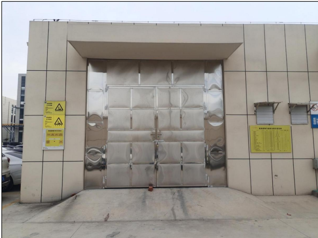
图4.1-5 危废暂存间图片
