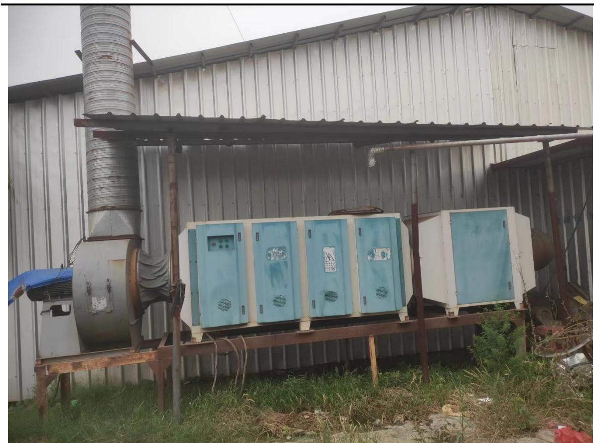
图8 过滤棉+UV 光氧+活性炭吸附装置
