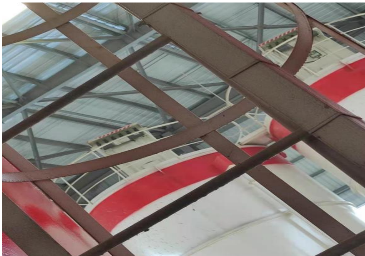
图 4 电磁脉冲除尘器
