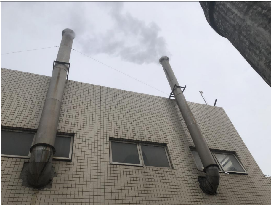
图3-2 锅炉废气排气筒
